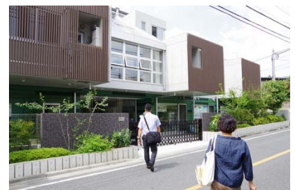
< 建物正面 (左側から見て) >
