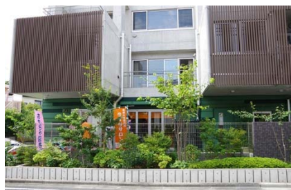
< 建物正面 (左側半分) >
